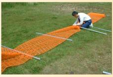
パイプをご希望のピッチにセットします。 パイプはネットの目合いに対して互い違いに 通します。50mmの径まで対応が可能です。
