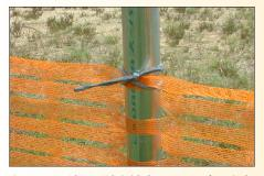
ネットの上端と下端を結束ヒモで固定します。 インシュロックを使うと簡単に固定できます。
